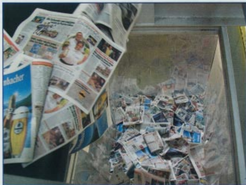
Durch flexible Abwurfschächte, ausgerüstet mit Schüttgutsensoren, gelangt das Druckpapier in die Container.
